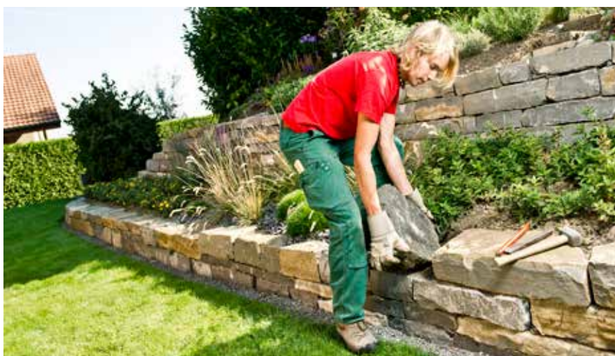
Trockenmauerbau gehört zu den Spezialitäten des Betriebes.
