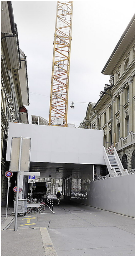
Die Baustelle Bild: Beat Mathys
